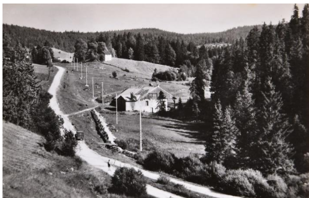
"Moulin brulé" ou usine Rosset vers 1950
